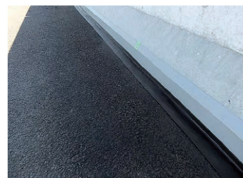
橋梁端部への適用事例
