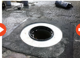
MR2モルタル打設
