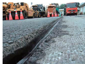
ピタっとL型止水テープ 設置状況
