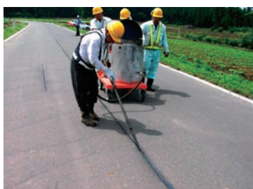
クラックシールNX 注入状況
